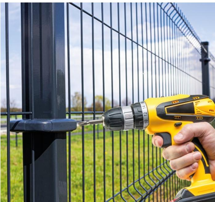
Mittelschellen aus Kunststoff sollten unter dem horizontalen Balken des Zaunfeldes vorhanden sein, während untere Schelle ueber der horizontalen Stange. So ist der Gittermattenzaun stabil auf Schellen basiert. Es wird empfohlen, 3 Sets von Schellen zu installieren ueber 1,5 m hoch.
