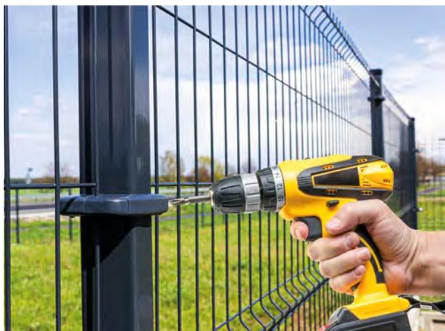
Mittelschellen aus Kunststoff sollten unter dem horizontalen Balken des Zaunfeldes vorhanden sein, waehrend untere Schelle ueber der horizontalen Stange. So ist der Gittermattenzaun stabil auf Schellen basiert. Es wird empfohlen, 3 Sets von Schellen zu installieren ueber 1,5 m hoch.
