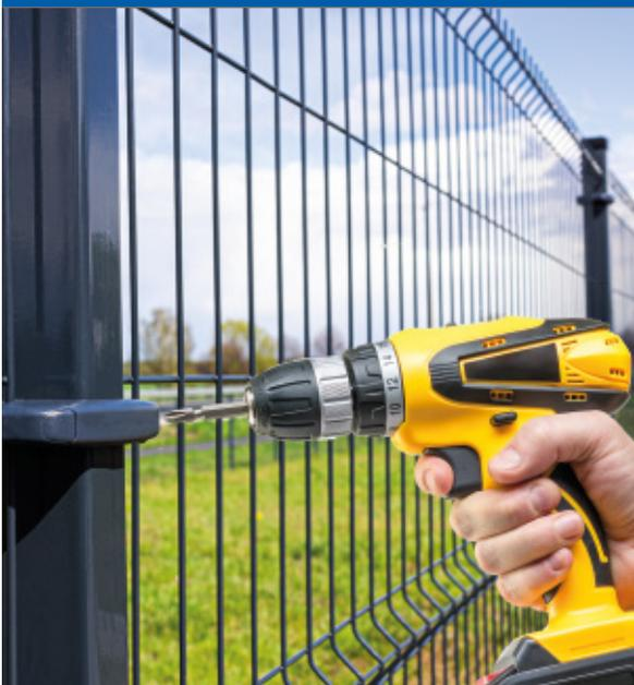
Mittelschellen aus Kunststoff sollten unter dem horizontalen Balken des Zaunfeldes vorhanden sein, während untere Schelle ueber der horizontalen Stange. So ist der Gittermattenzaun stabil auf Schellen basiert. Es wird empfohlen, 3 Sets von Schellen zu installieren ueber 1,5 m hoch.
