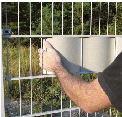
Fechtbaender, die an den Gittermattenzaeunen befestigt werden.
